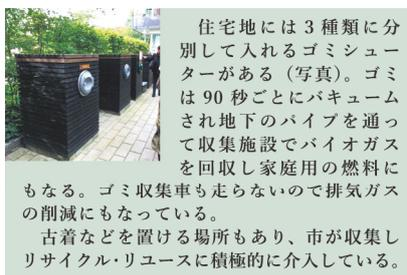
住宅地には3種類に分別して入れるゴミシューターがある(写真)。ゴミは90秒ごとにバキュームされ地下のパイプを通って収集施設でバイオガスを回収し家庭用の燃料にもなる。ゴミ収集車も走らないので排気ガスの削減にもなっている。古着などを置ける場所もあり、市が収集しリサイクル・リユースに積極的に介入している。
